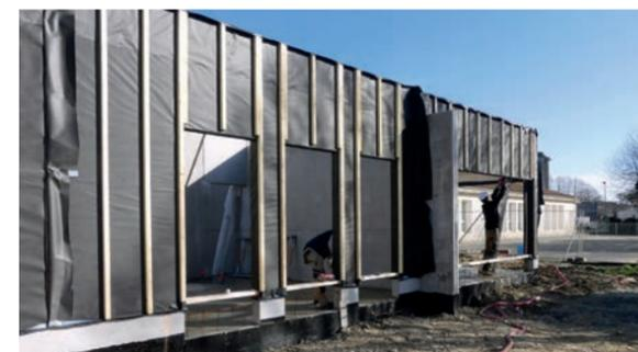
Le chantier de rénovation maintient son rythme. Le gros œuvre est maintenant terminé et les murs finis en ossature bois sont posés, ainsi que les charpentes. Les travaux permettront d'améliorer les qualités structurelles, thermiques et acoustiques.
